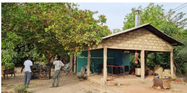
Terrein met overdekte werkplaats
